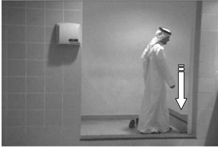
شكل 1 ج خط المنطقة الطاهرة محدد بوجود سور منخفض
